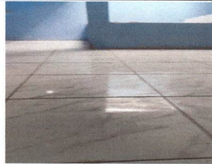
Foto 10: ceramica colocada y pintura de pared
