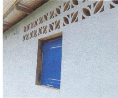
Foto 2: colocación de ventana
