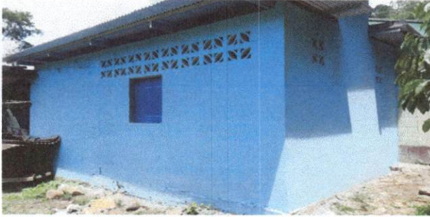
Foto7: ampliación de cocina
